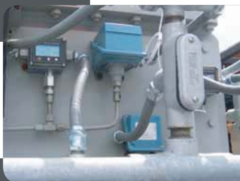
Прибор One Series , установленный на изолирующем кольце для контроля сточных вод
